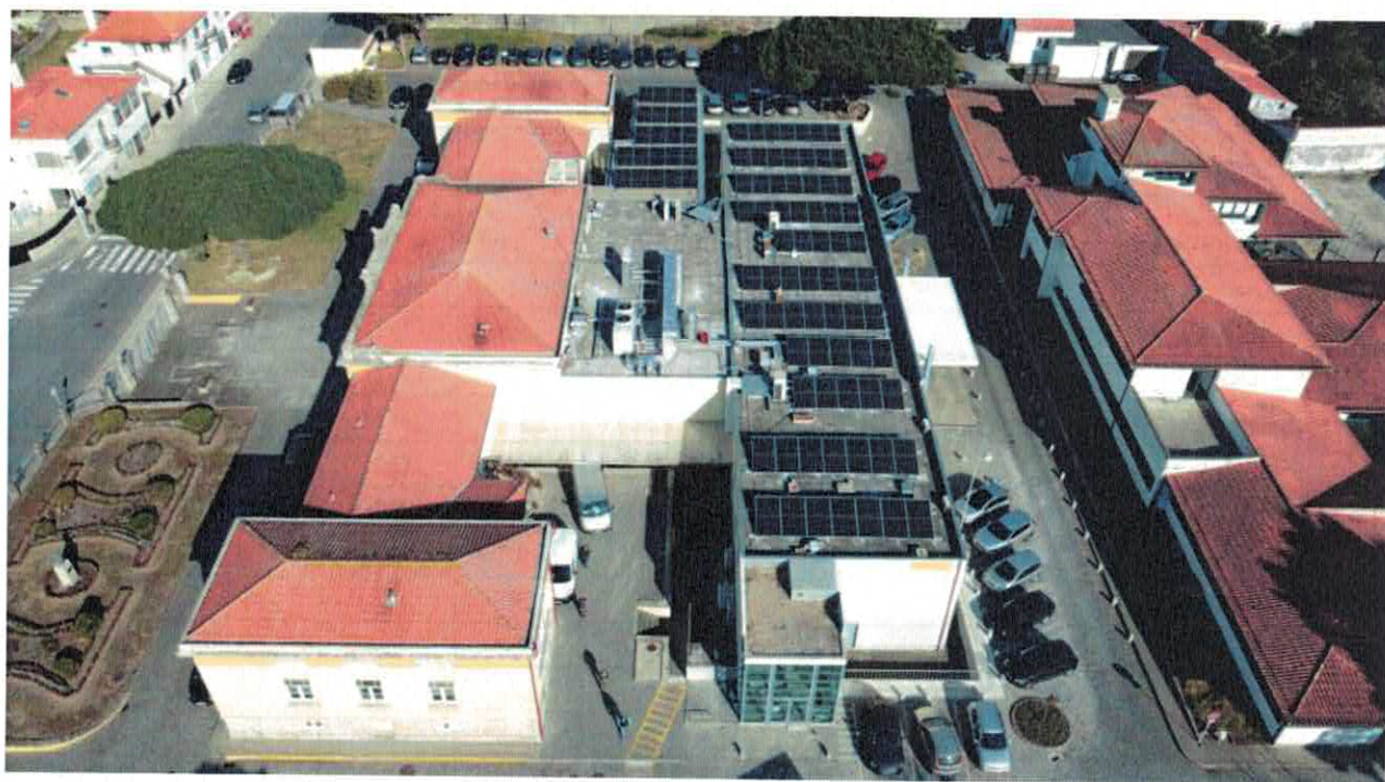
Imagem 2 - Instalação de sistema fotovoltaico na cobertura do Hospital de Esposende
